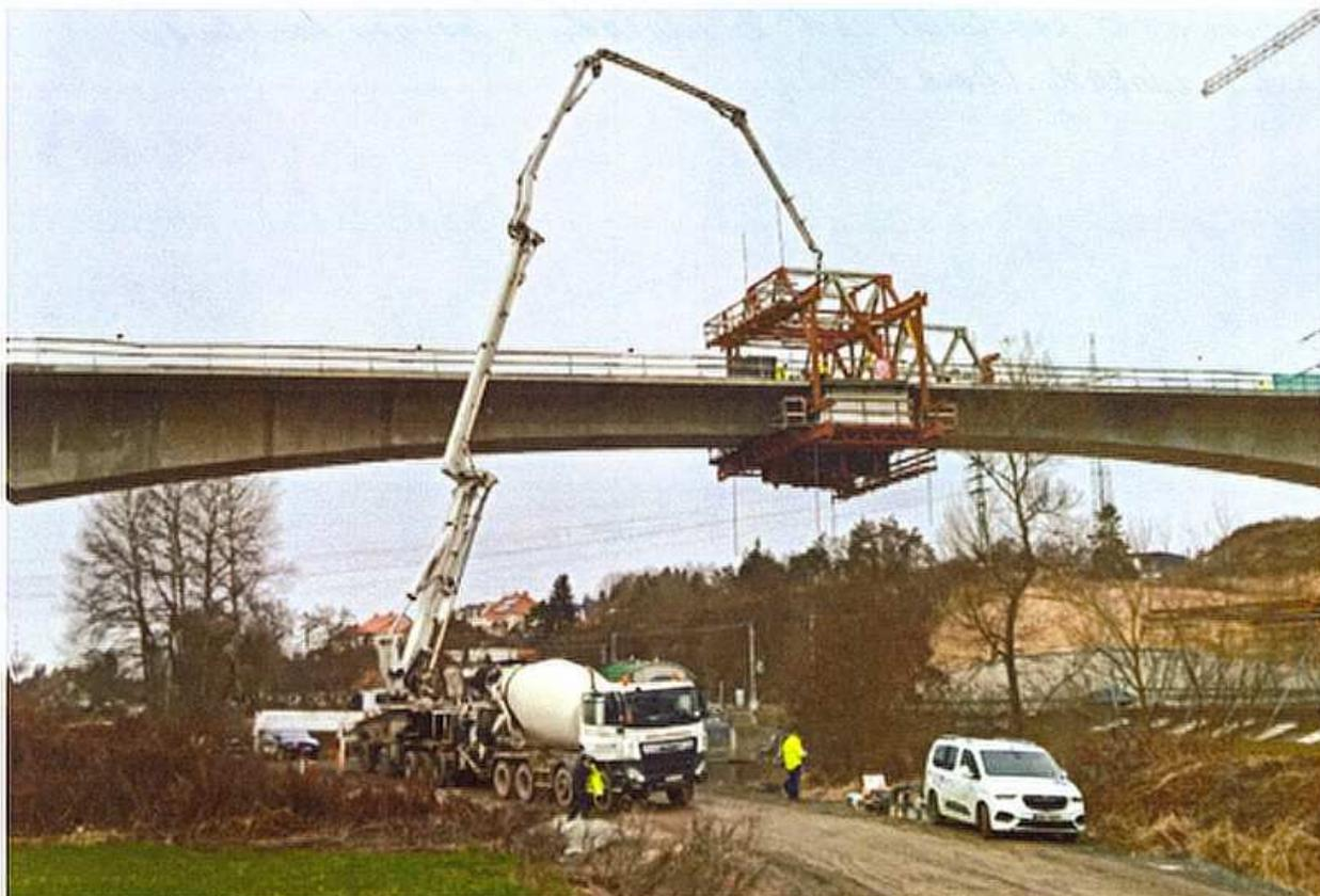
**Propojení nosné konstrukce části B estakády s nosnou konstrukcí části C estakády.**
